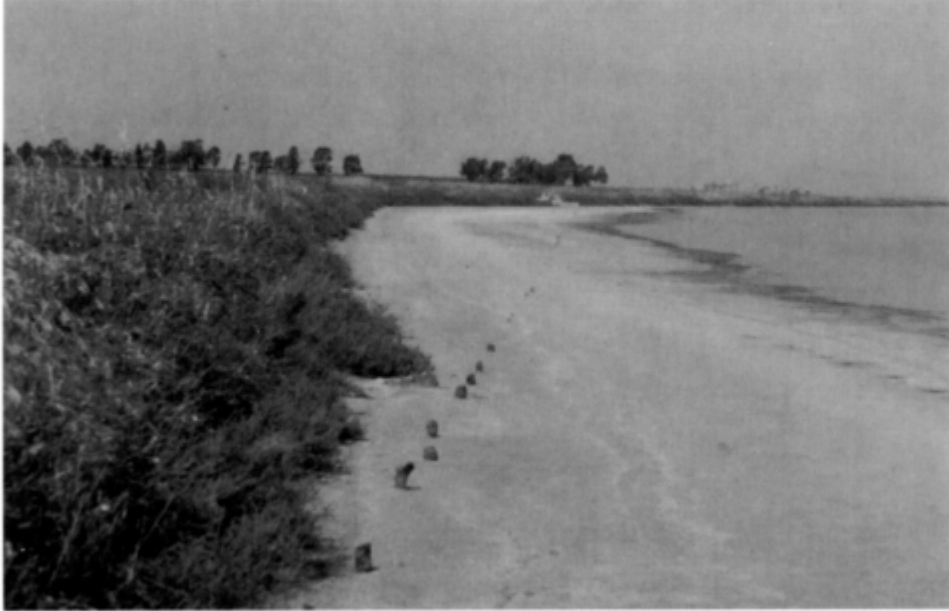
Fig. 93 - Particolare paletti in legno.
